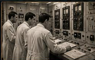
El equipo en la sala de control momentos antes.
